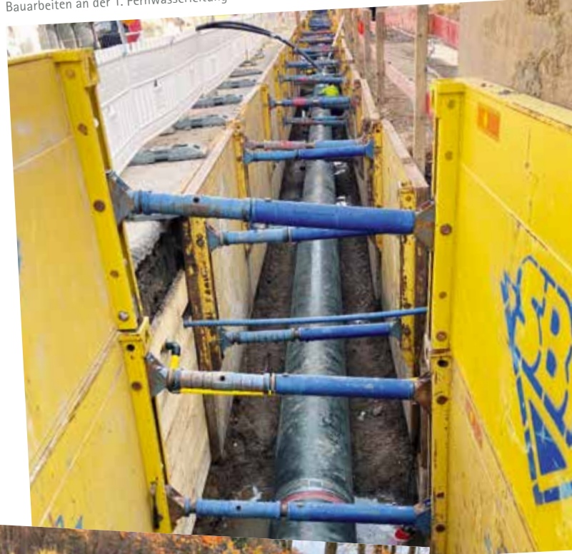
Bauarbeiten an der 1. Fernwasserleitung.
