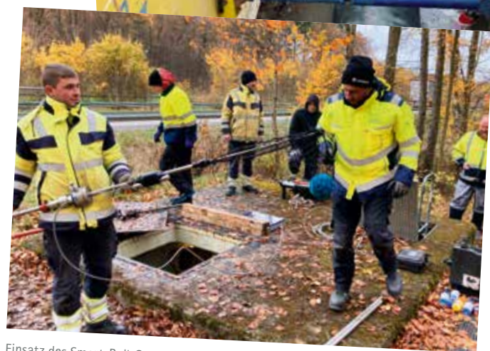
Einsatz des Smart-Ball-Systems zur Erkennung von Lecks.
