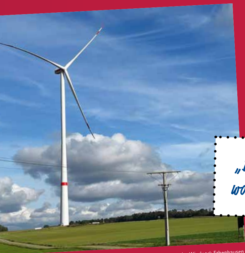
Erfolgreiche Repowering-Maßnahme im Windpark Erbenhausen.
