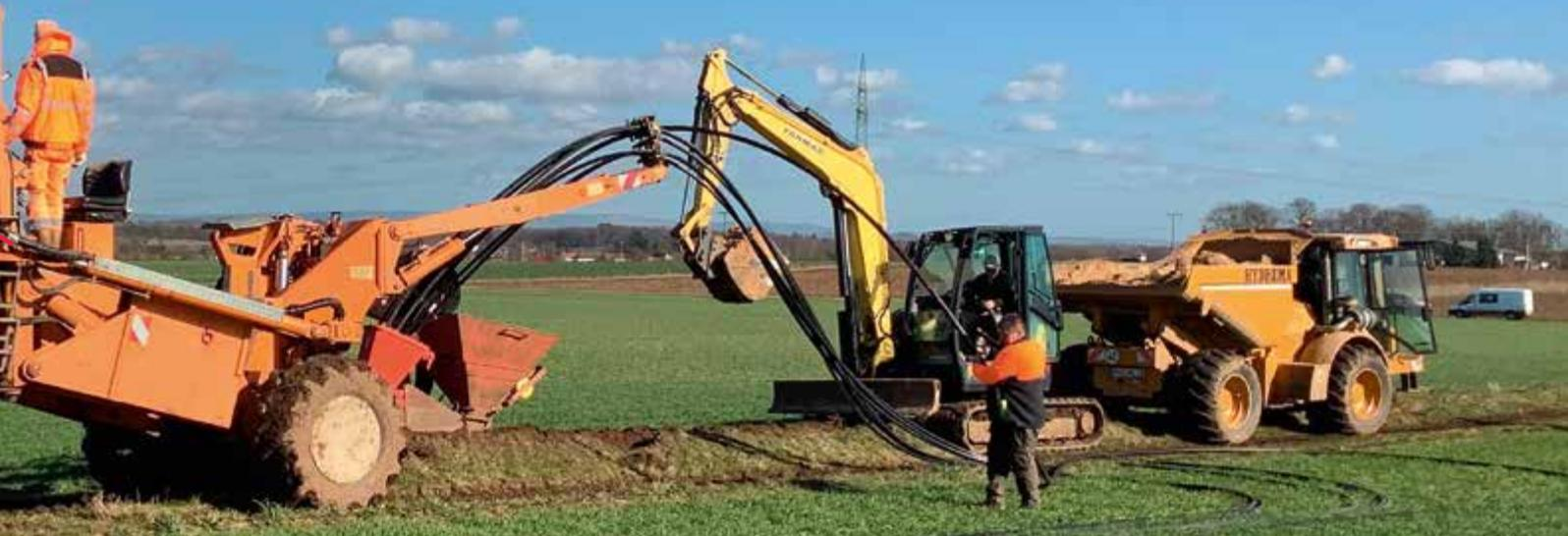
parallel bis zur Schwerpunktstation Lich verlegt. Eines der beiden Kabel dient dabei zur Absicherung. Dank der neuen Erdverkabelung kann künftig deutlich mehr Strom vom Umspannwerk, in dem die Spannung von 110 kV auf 20 kV heruntertransformiert wird, nach Lich transportiert werden.
