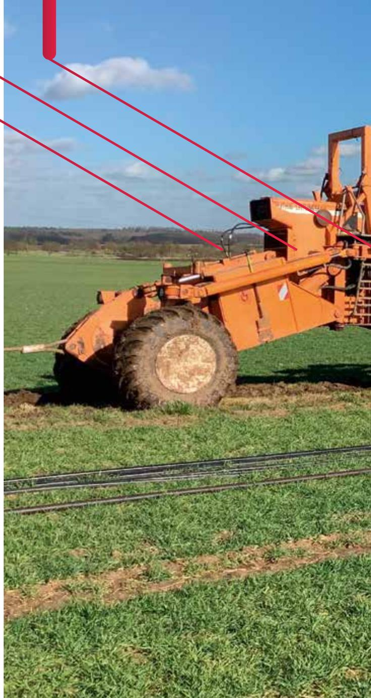
Verlegung von 20-kV-Kabeln bei Hungen mit einem Kabelpflug
