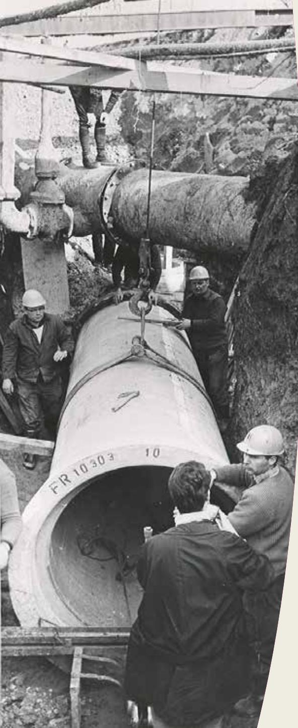
Mit schwerem Gerät und Manpower wird 1967 ein Rohr der 2. Fernwasserleitung Inheiden-Frankfurt verlegt. Das unter anderem in den 70er Jahren erweiterte Wasserwerk in Inheiden (Fotos auf der rechten Seite) versorgt heute rund 750.000 Menschen mit Trinkwasser.
