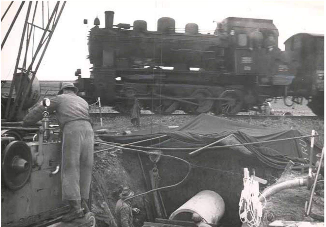
Durchpressung des Senkrohres an der Bahnlinie Bad Nauheim – Rockenberg, 1960
