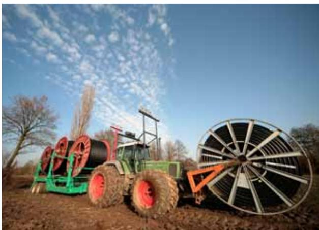
Pflüge- und Muffearbeiten an der 110 kV-Erdverkabelung bei Altenstadt, 2009
