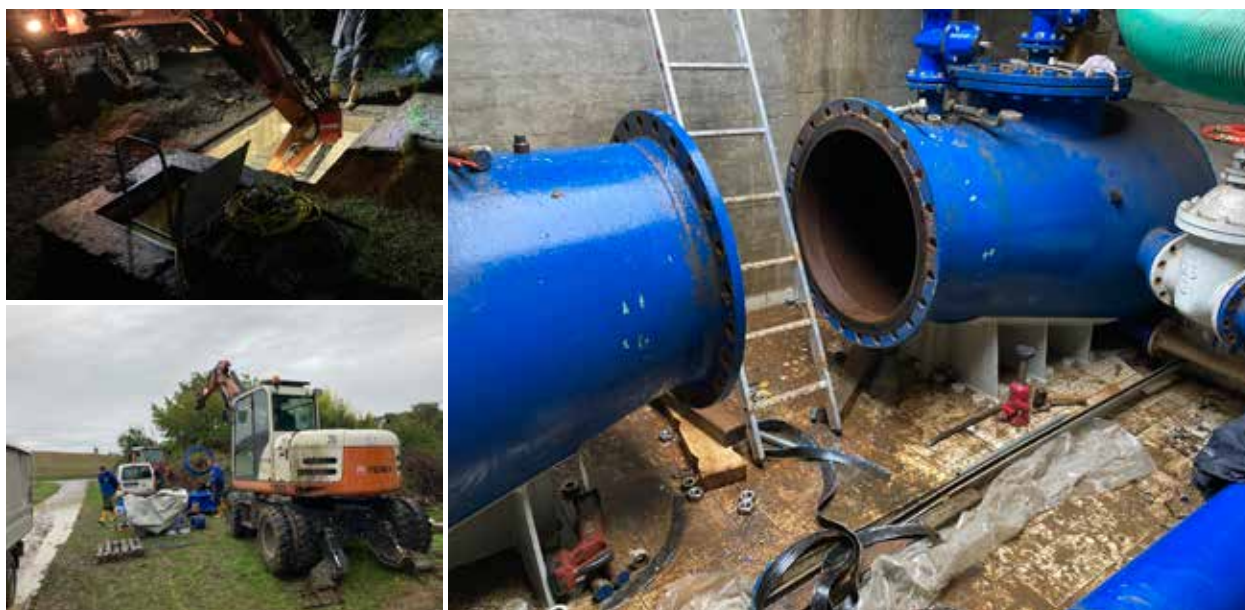
30 Stunden dauert der Austausch. Die Frühschicht beginnt zunächst mit der Entleerung der Leitung, gegen 22 Uhr sind die Arbeiten exakt nach Zeitplan abgeschlossen, die Frühschicht des folgenden Tages beginnt dann mit der erneuten Inbetriebnahme der Leitung.
