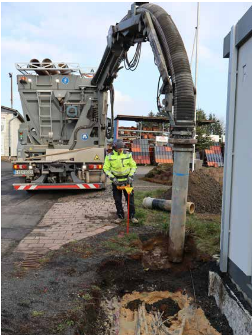
Der Einsatz eines Saugbaggers kommt immer dann infrage, wenn herkömmliche Aushubtechniken ein zu großes Beschädigungsrisiko darstellen.
