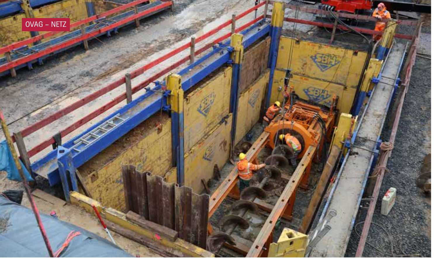
Mittels Bohr-Pressverfahren werden am Umspannwerk zwei Stahlröhren verlegt, die direkt unter der viel befahrenen Main-Weser-Bahn hindurchführen.
