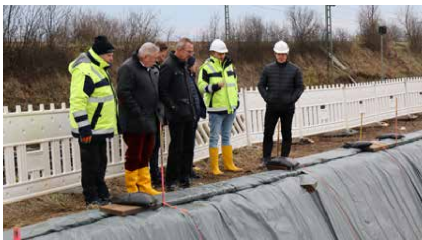
Die beiden OVAG-Vorstände Oswin Veith und Joachim Arnold (2. und 3. v.l.) bei der Besichtigung der Baustelle.
