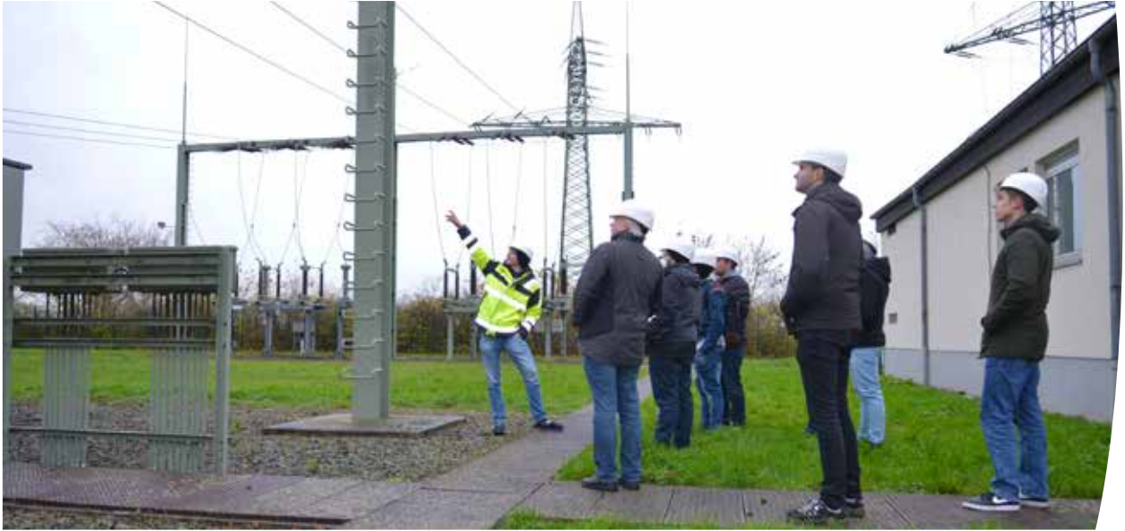
Carsten Eckhold (l.) und Manuel Christ (2.v.r.) führen die Studenten sowie Dr. Ing. Steffen König und Benjamin Wörner, beide Fachbereich Informationstechnik-Elektrotechnik-Mechatronik, über das Gelände des Umspannwerks in Friedberg-Fauerbach.
