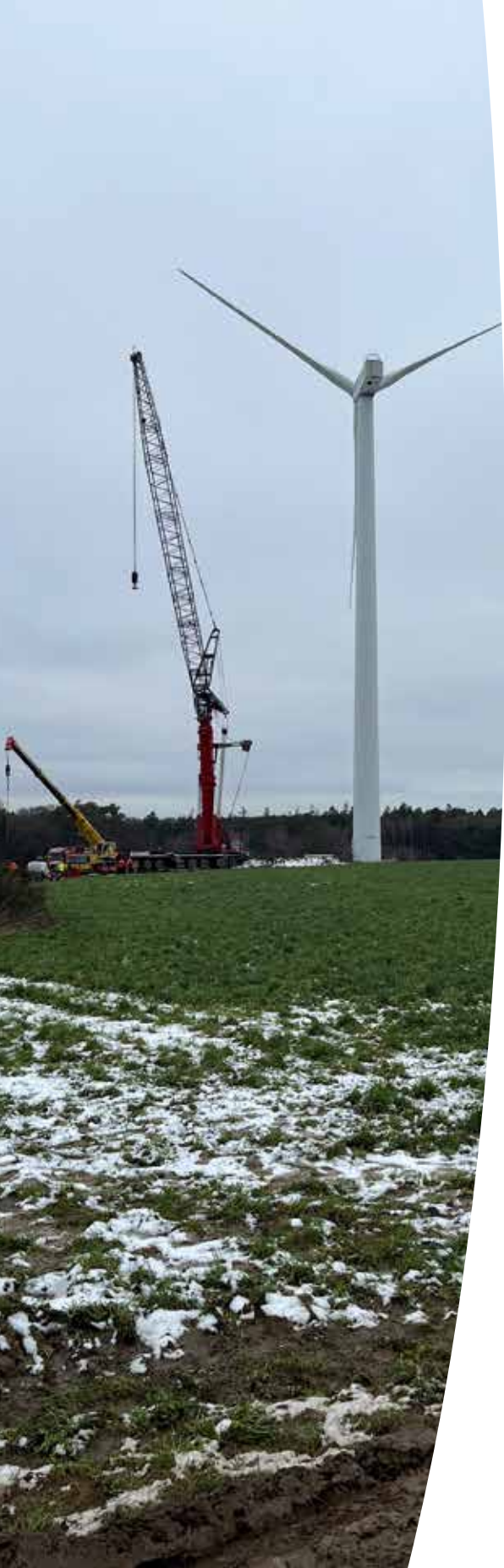
Der Rückbau (oben und rechts unten) ist nachhaltig: die Stahltürme, Bewehrungsseisen und gesprengten Betonfundamente wurden recycelt.
