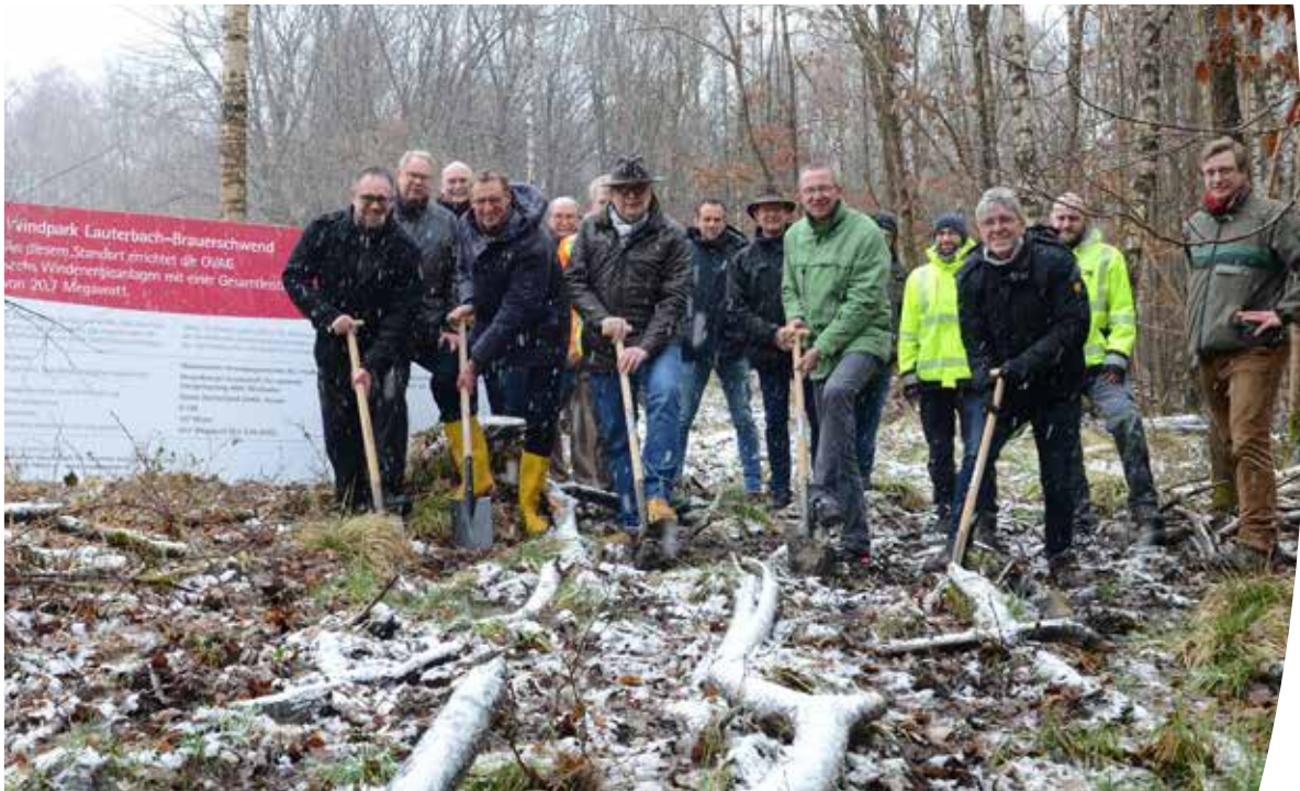
Die OVAG-Vorstände Joachim Arnold und Oswin Veith (vorne, Mitte) beim symbolischen ersten Spatenstich mit HessenEnergie-Geschäftsführer Hans-Peter Frank (vorne, 2.v.l.).
