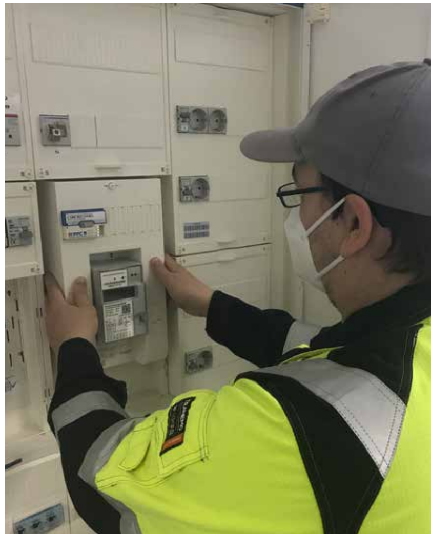
David Wiedlocha baut ein intelligentes Messsystem ein.
