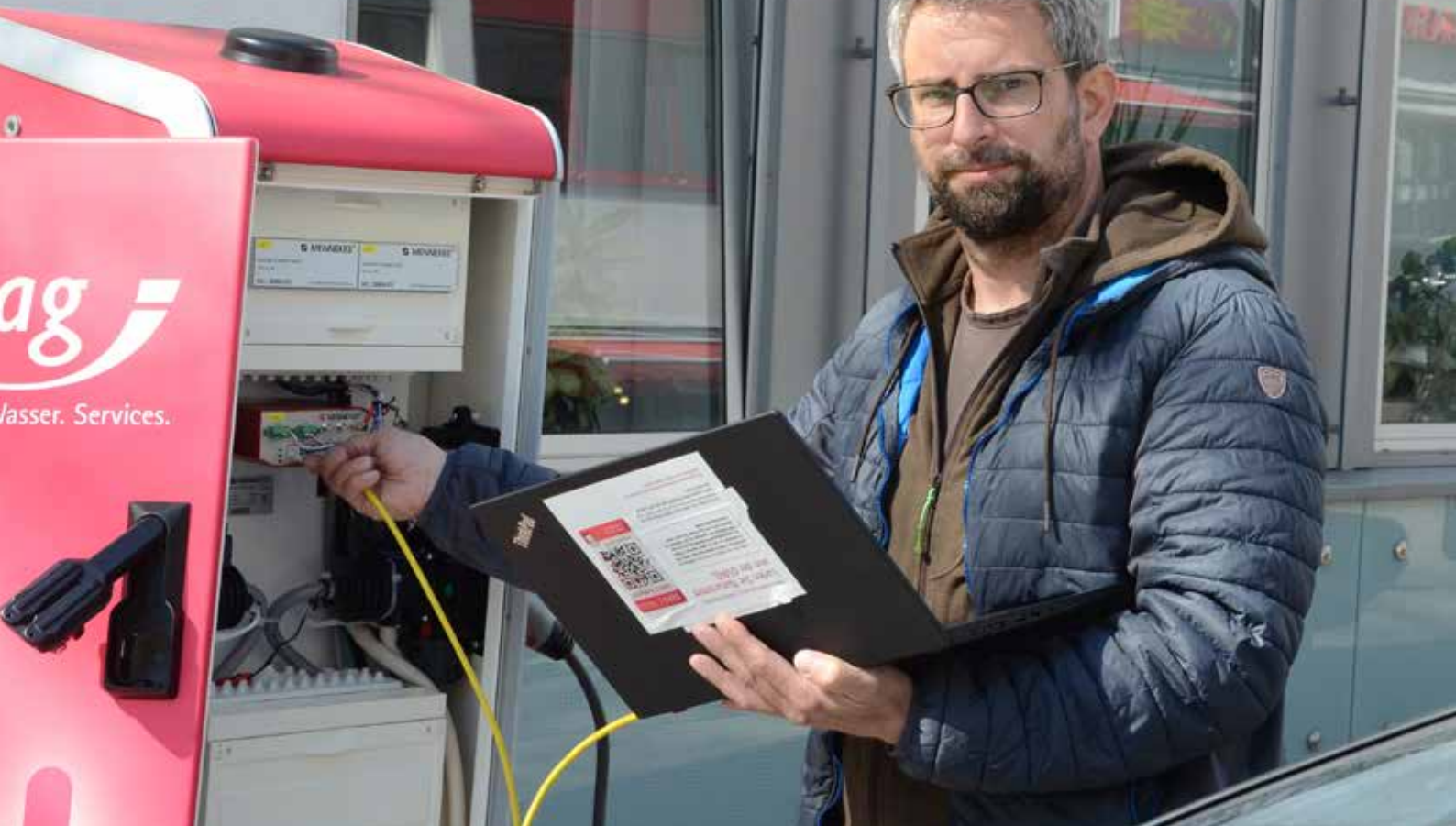
Dirk Schneider richtet jede neue Ladesäule vor Ort ein.
