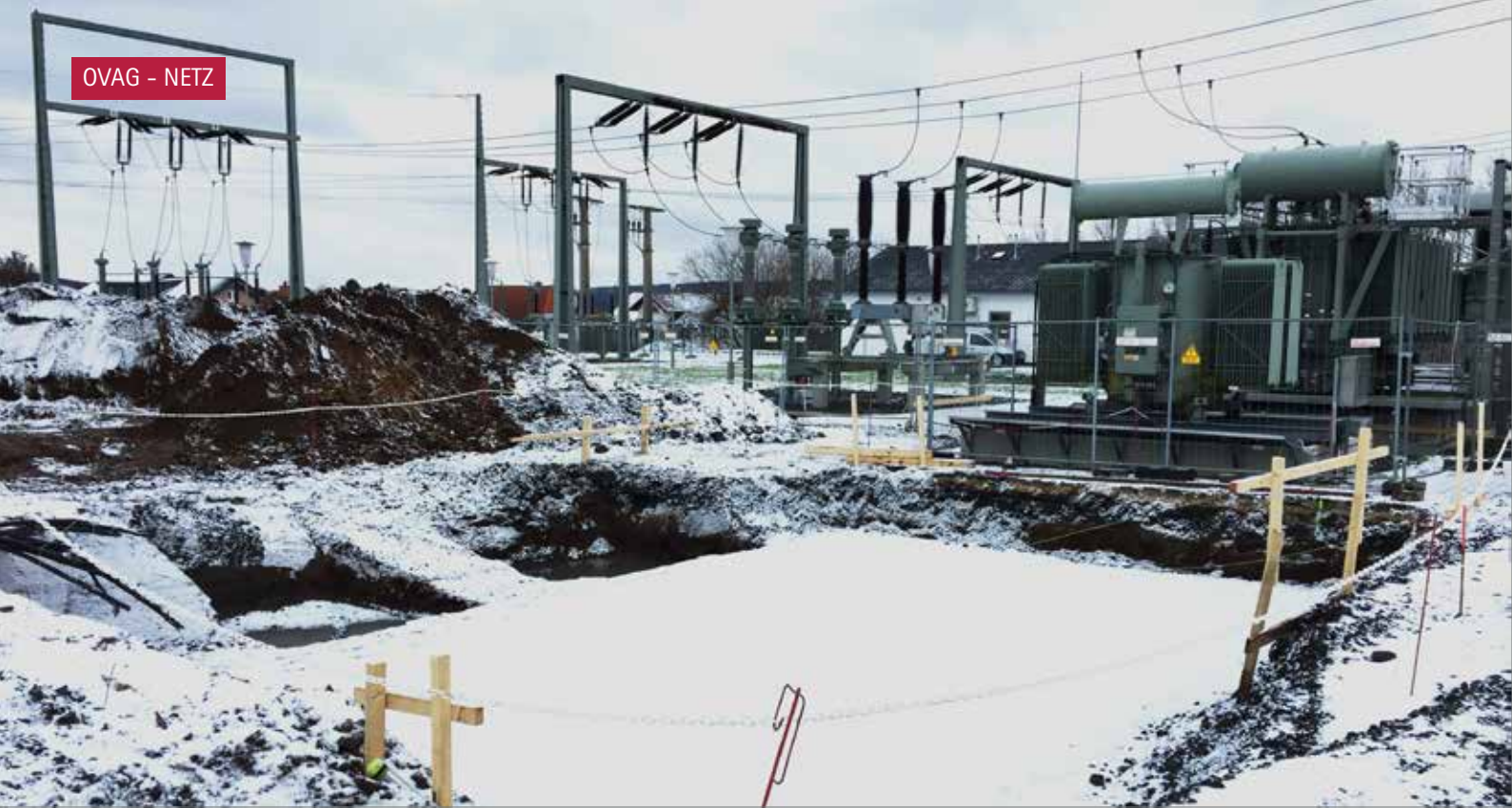
Die Baugrube für das neue Trafofundament vor der bestehenden 110 kV-Anbindung des Umspannwerkes
