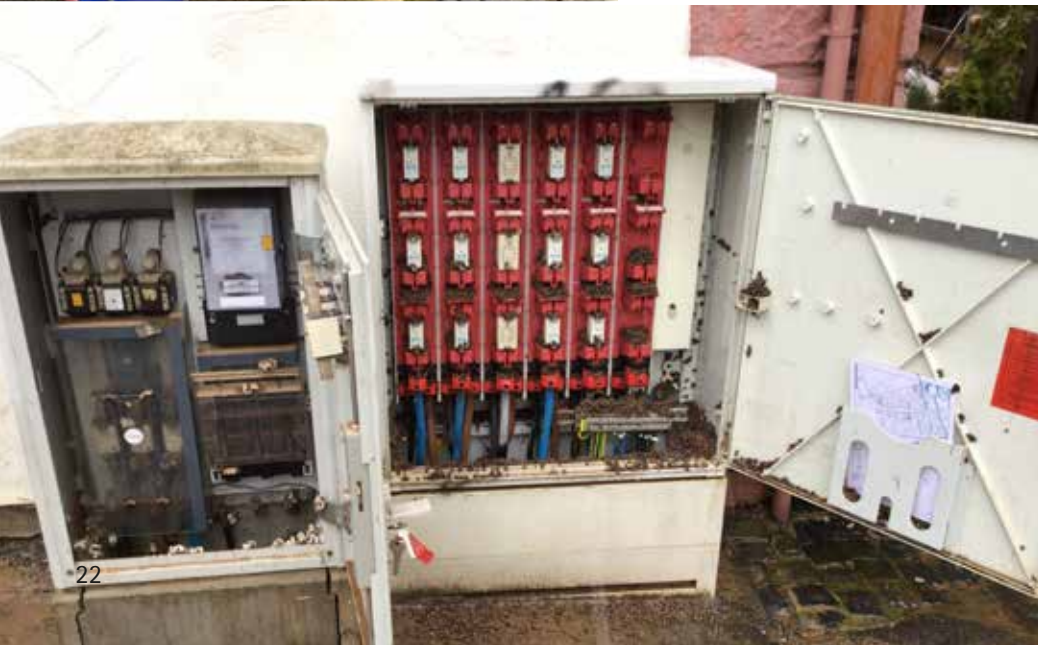
Trocknen, säubern und testen – sowohl bei der Elektroladesäule (links) als auch bei den Verteilerkästen, die komplett unter Wasser standen.
