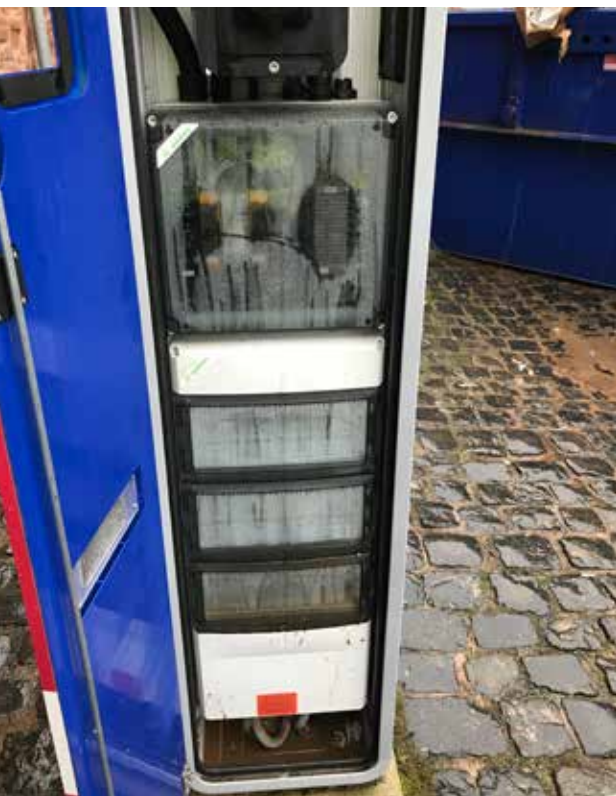
Trocknen, säubern und testen – sowohl bei der Elektroladesäule (links) als auch bei den Verteilerkästen, die komplett unter Wasser standen.
