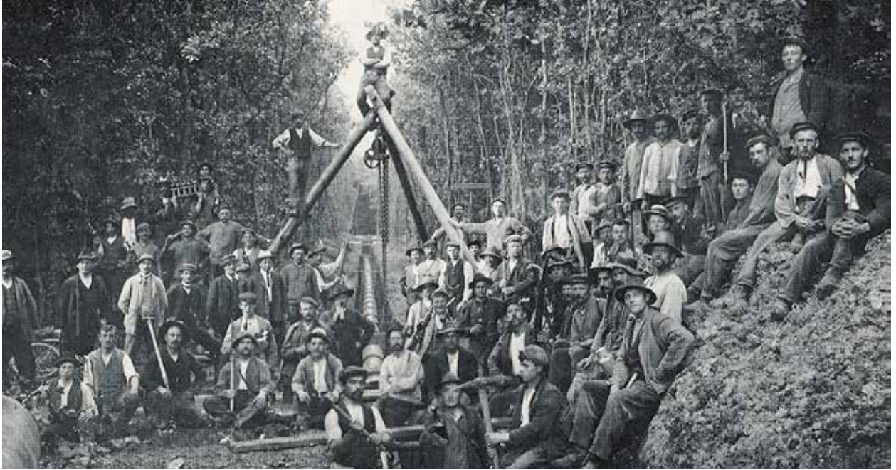
1909: Die Fernwasserleitung zwischen Inheiden und Frankfurt wird gebaut. Die meisten Arbeiter sind italienische Gastarbeiter.
