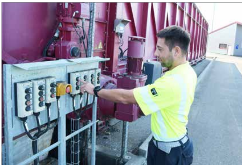
Sebastian Roch bedient im Freien den Feststoffdosierer 1, der die Zufuhr von Feststoffen in den Fermenter regelt. In 24 Stunden werden in 12 Zyklen etwa 40 Tonnen Silage pro Fermenter dem Prozess zugegeben.
