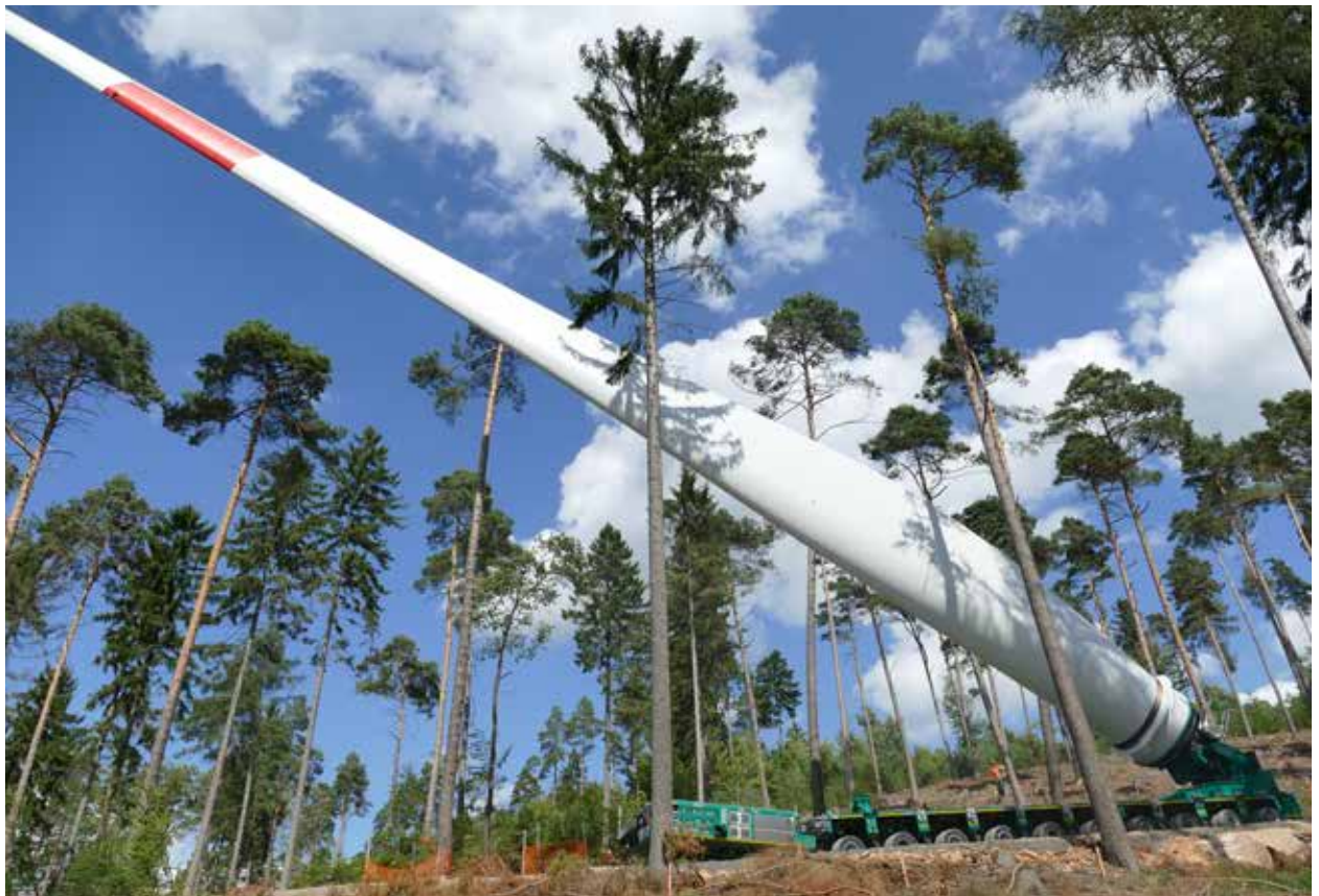
Fotos vom Bau des Wartenerger Windparks zeigen die Größenverhältnisse der Rotorblätter, die per ferngesteuertem Transportfahrzeug im Schrittempo zum Standort gebracht wurden.
