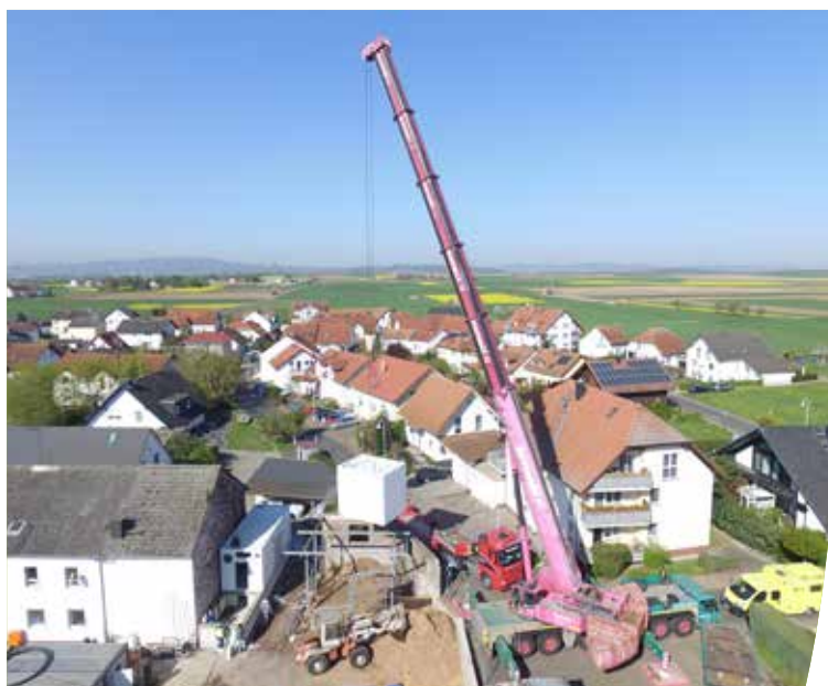
Die Bauarbeiten an der Heizzentrale von oben
