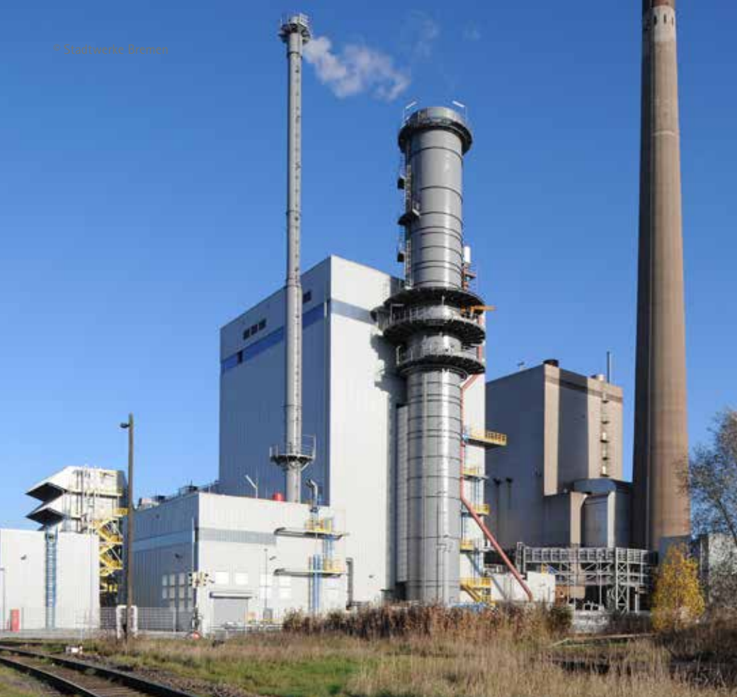
Auch hier ist die OVAG beteiligt: das effiziente, moderne und klimaschonende Gas- und Dampfturbinenkraftwerk in Bremen.
