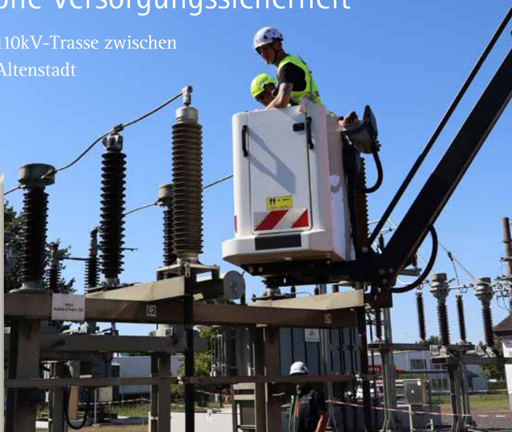
Bei der turnusmäßigen Überprüfung werden sowohl die sogenannten Endverschlüsse im Umspannwerk als auch das Kabel selbst geprüft.
