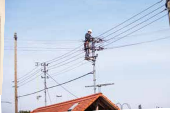
Kein Bürojob: Als Elektroanlagenmonteur geht es ab und zu auch mal hoch hinaus.
