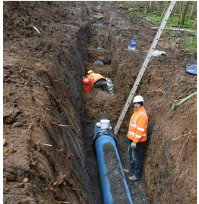
Letzte Handgriffe, bevor das nächste Rohr in den vorbereiteten Graben eingehoben wird.
