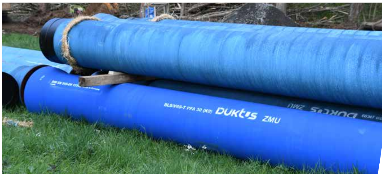
Die neuen Rohre warten bereits darauf, verlegt zu werden, ...
