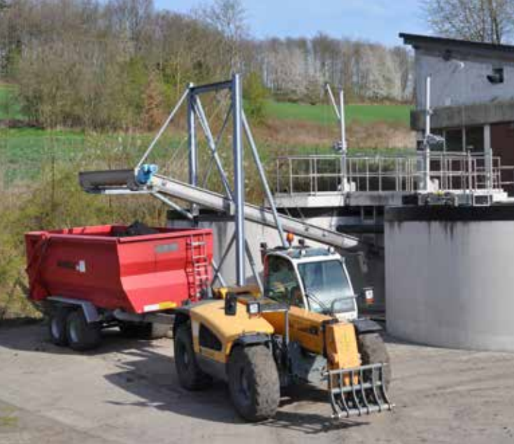
Entwässerter Klärschlamm wird in der Kläranlage in Nidda verladen.
