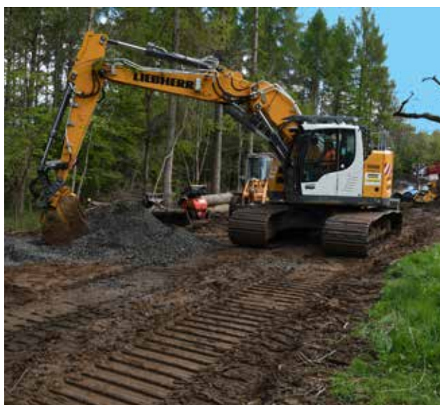
... während die alten Grauguss-Rohre aus der Erde geholt werden.
